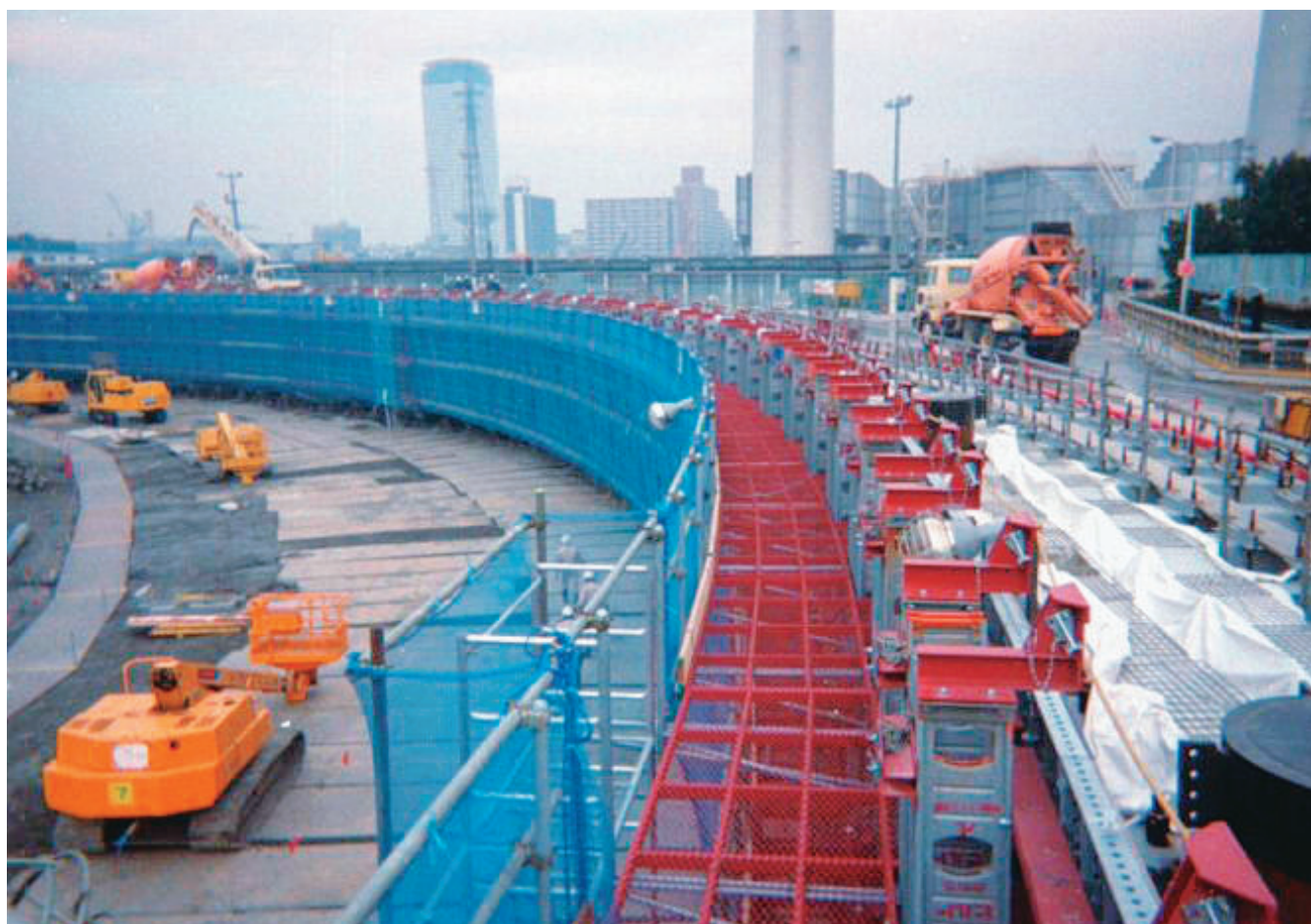
円形コンクリートタンク
