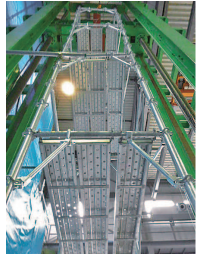
支柱強化の荷重試験
