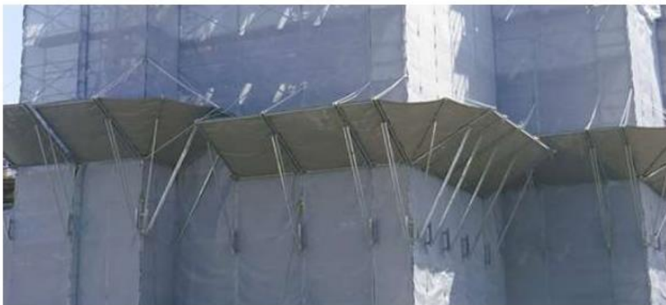
入り隅コーナー オプション部材の隙間塞ぎシートを用いことでどんな足場でも隙間なく設置できます 内コーナー、外コーナー対応 足場内で設置可能
