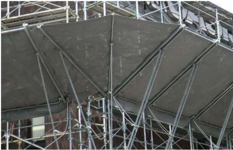
特殊（鈍角）コーナー 足場内で作業できます
